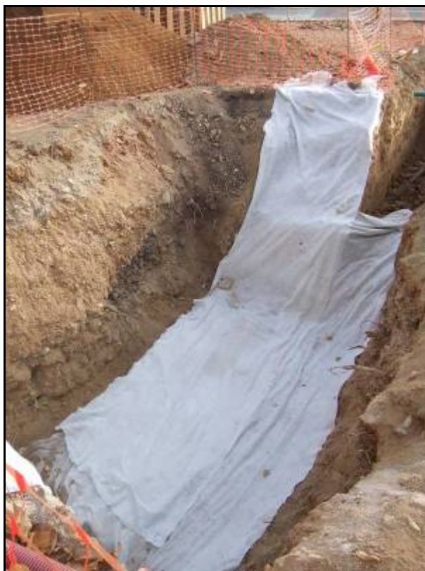
Fotografia núm. 29: cobertura de les estructures a la rasa 1000
