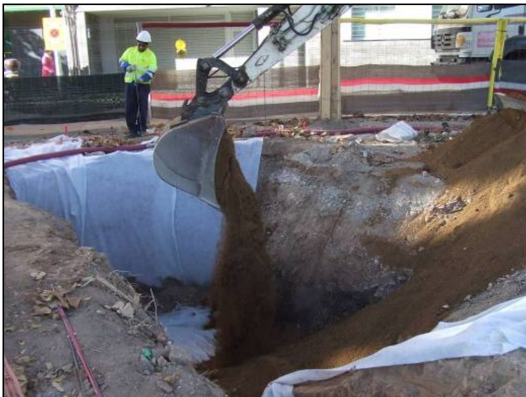
Fotografia núm. 31: cobertura de les estructures a la rasa 1000
