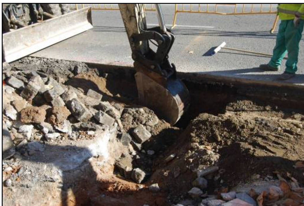
Fotografia núm. 50: obertura de l'espai per l'embornal 5
