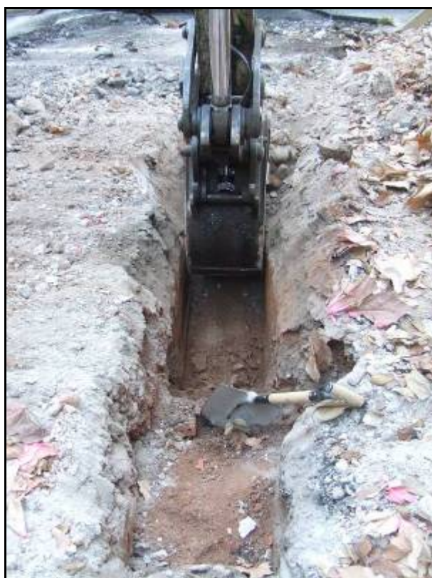
Fotografia núm. 48: obertura de la rasa 3000
