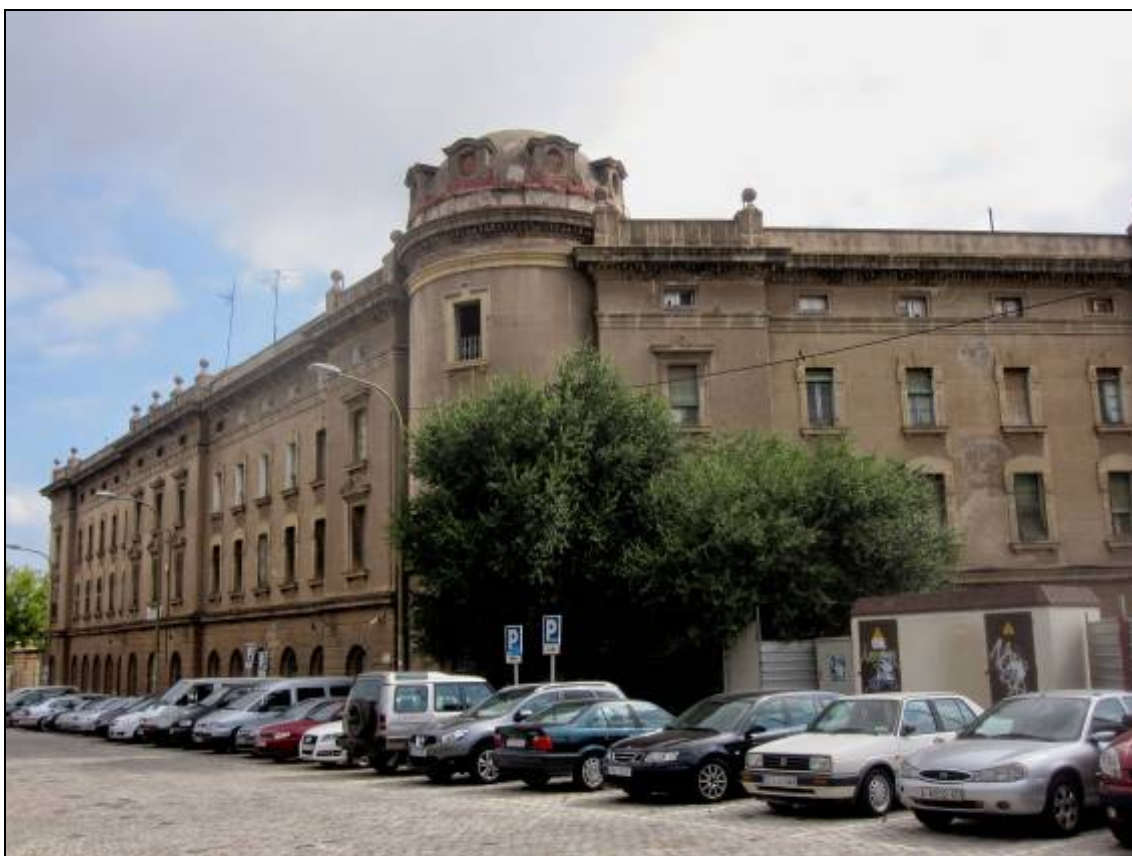
Antic edifici administratiu de l'estació de mercaderies La Sagrera-El Clot (autor)
