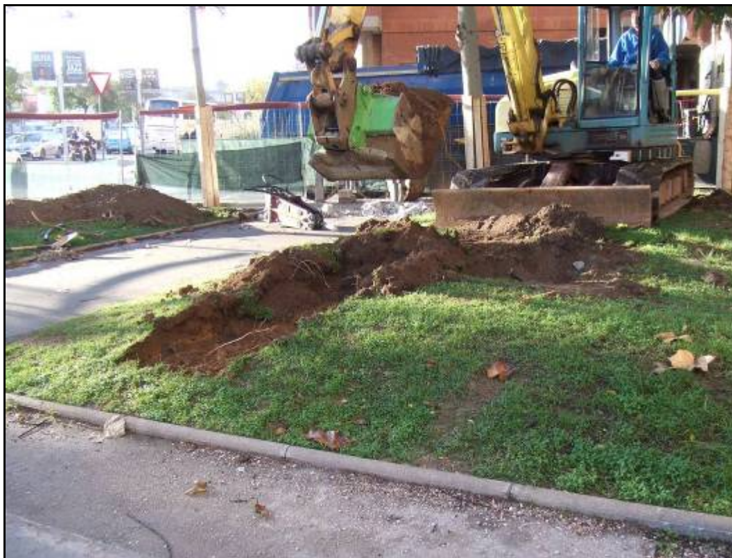
Fotografia núm. 2: desmantellament dels parterres existents
