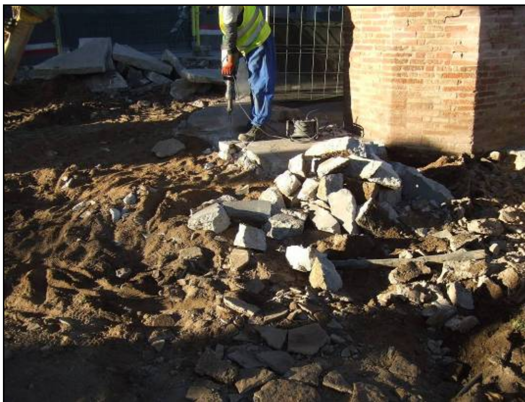
Fotografia núm. 6: desmantellament de paviment al voltant del pilar d'aigua
