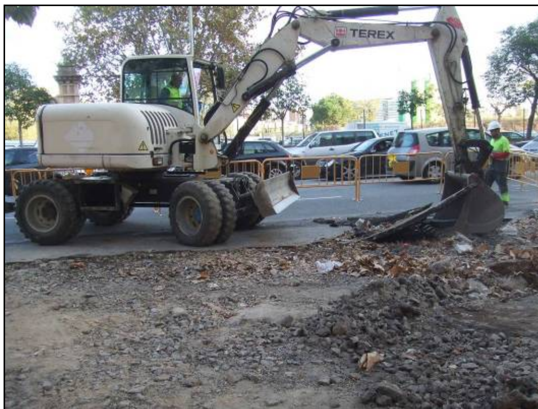
Fotografia núm. 5: desmantellament de paviments existents
