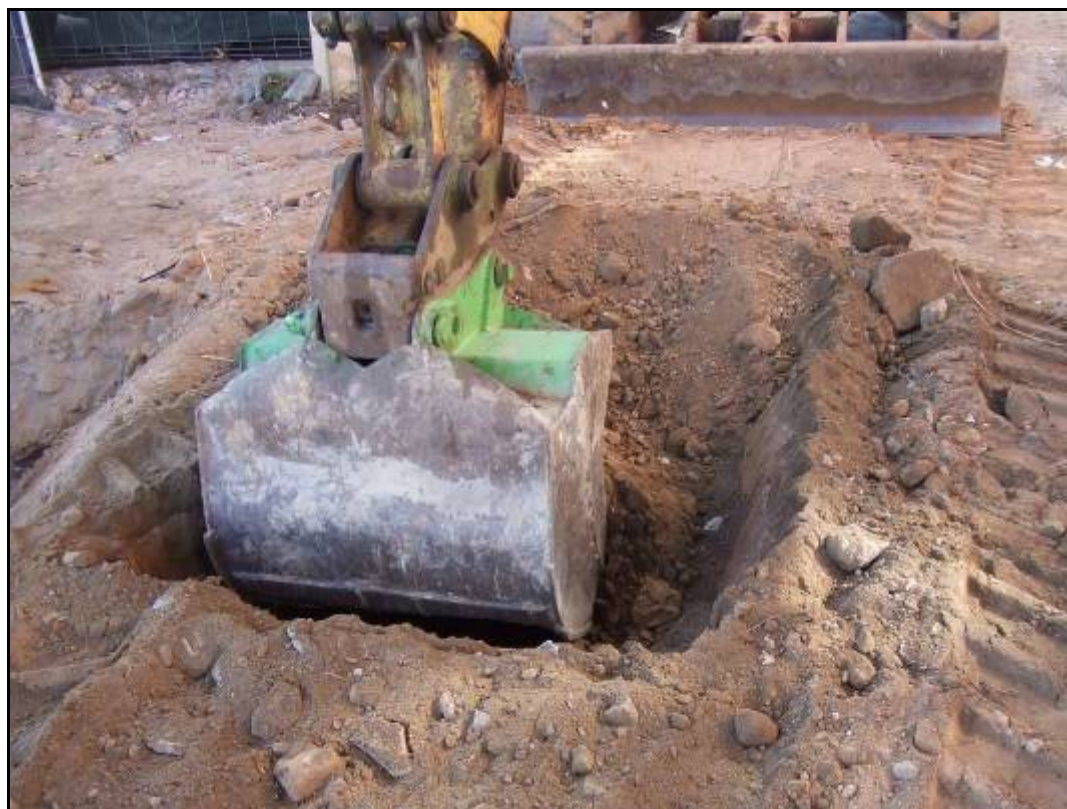
Fotografia núm. 8: obertura de la rasa 1000
