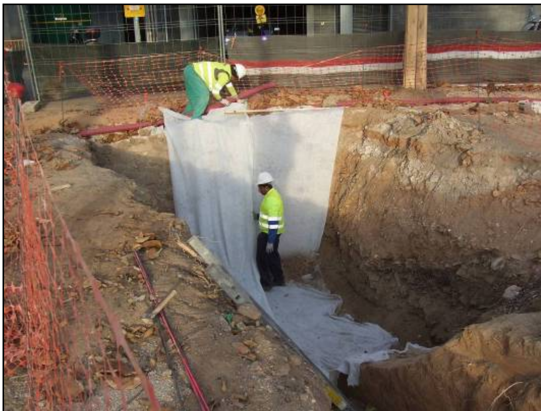
Fotografia núm. 27: cobertura de les estructures a la rasa 1000
