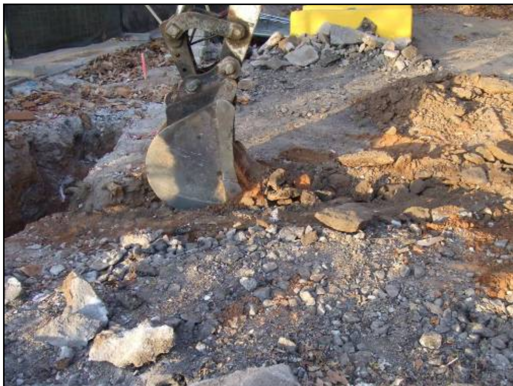
Fotografia núm. 54: obertura de la rasa 4000
