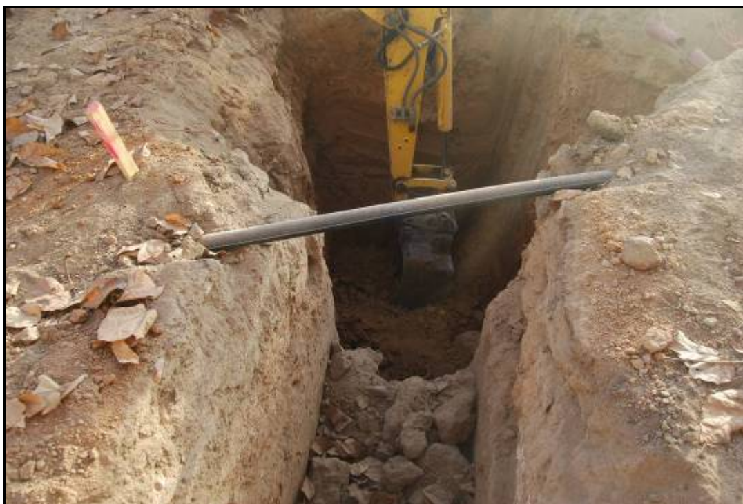
Fotografia núm. 46: excavació del pou 1
