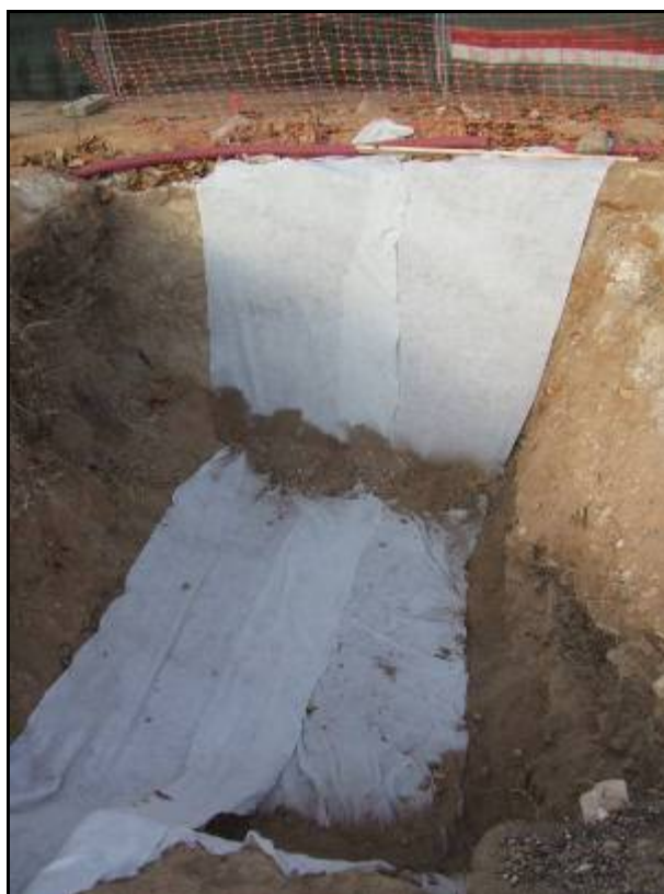
Fotografia núm. 28: cobertura de les estructures a la rasa 1000
