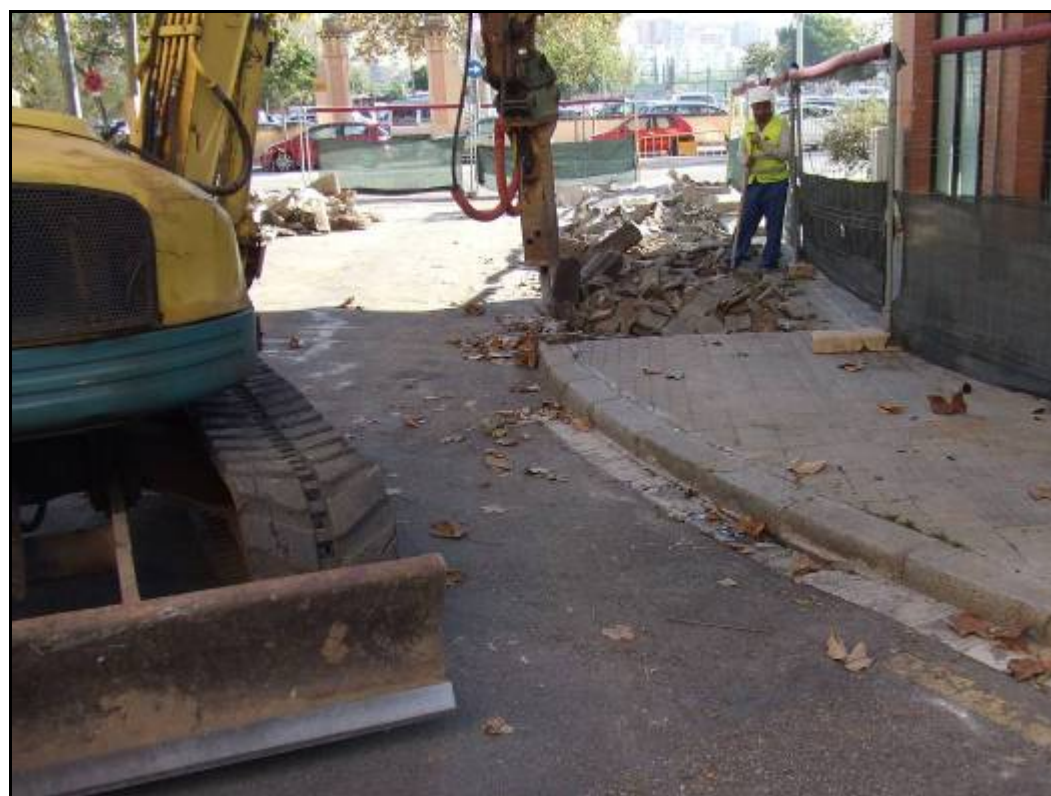
Fotografia núm. 4: desmantellament de paviments existents
