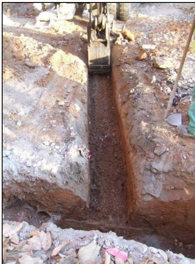
Fotografia núm. 55: obertura de la rasa 4000
