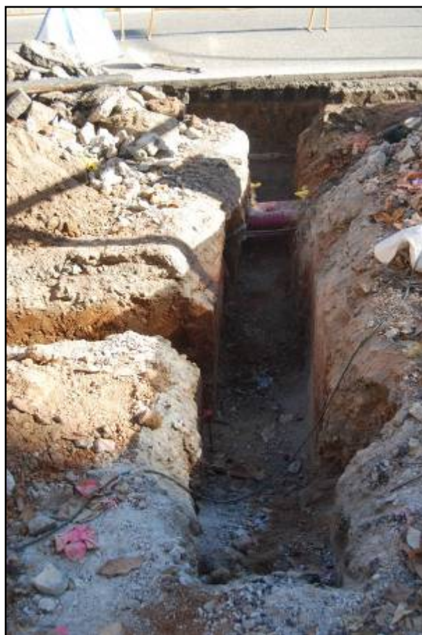
Fotografia núm. 49: rasa 3000 un cop finalitzada
