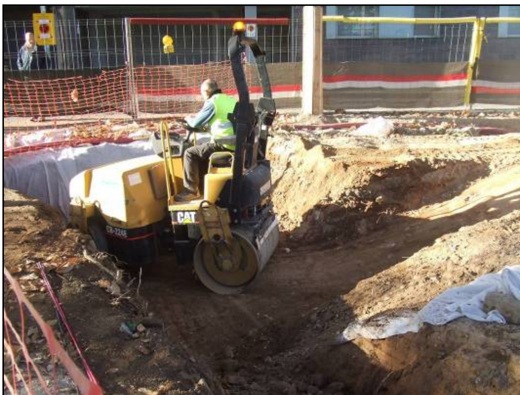
Fotografia núm. 32: cobertura de les estructures a la rasa 1000
