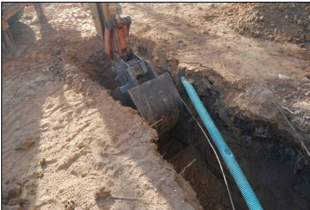
Fotografia núm. 39: obertura de la rasa 2000
