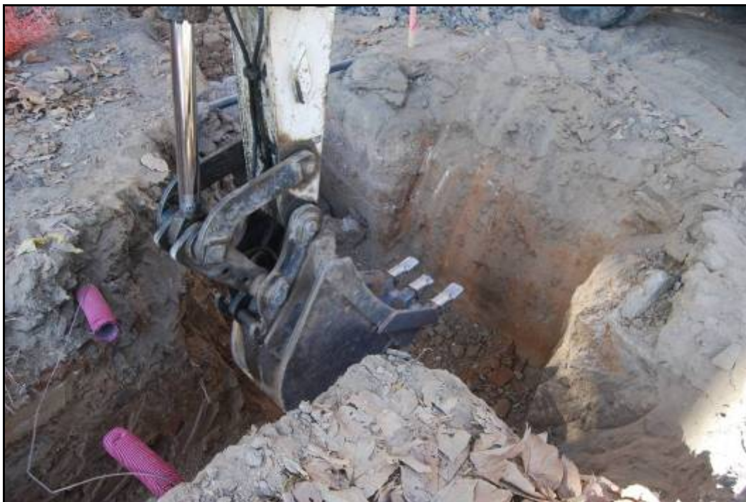
Fotografia núm. 45: excavació del pou 1
