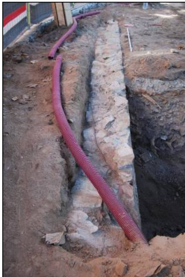
Fotografia núm. 18: UE 1005 en planta. Vista NE
