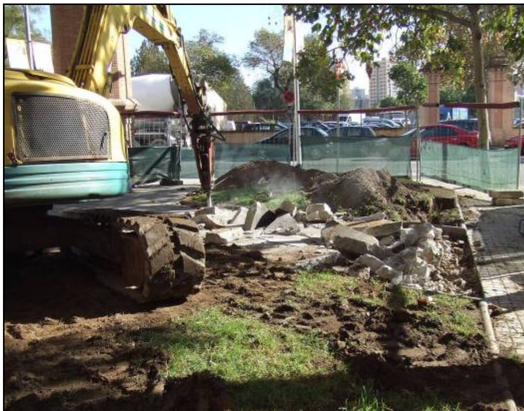
Fotografia núm. 3: desmantellament de paviments existents
