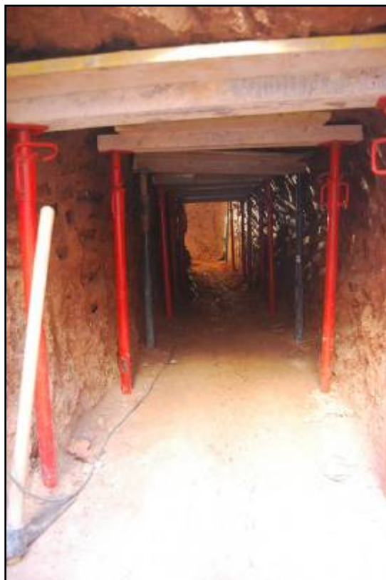
Fotografia núm. 57: procés de minat per sota del carrer Gran de la Sagrera
