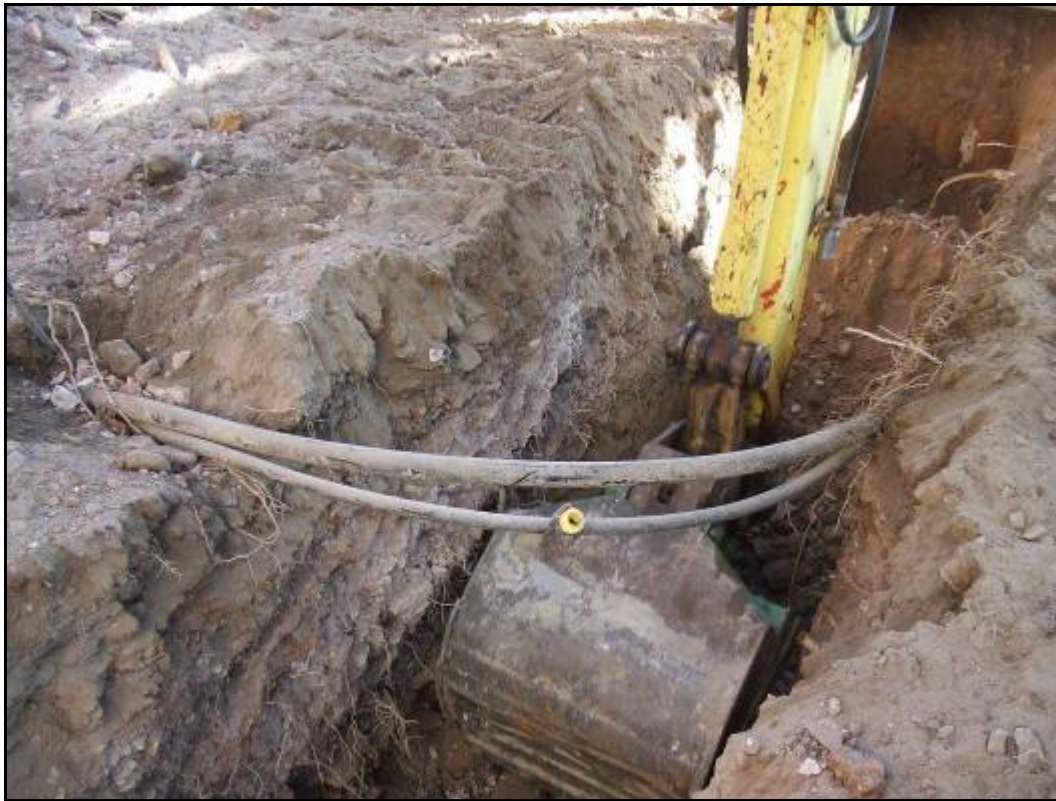
Fotografia núm. 9: obertura de la rasa 1000
